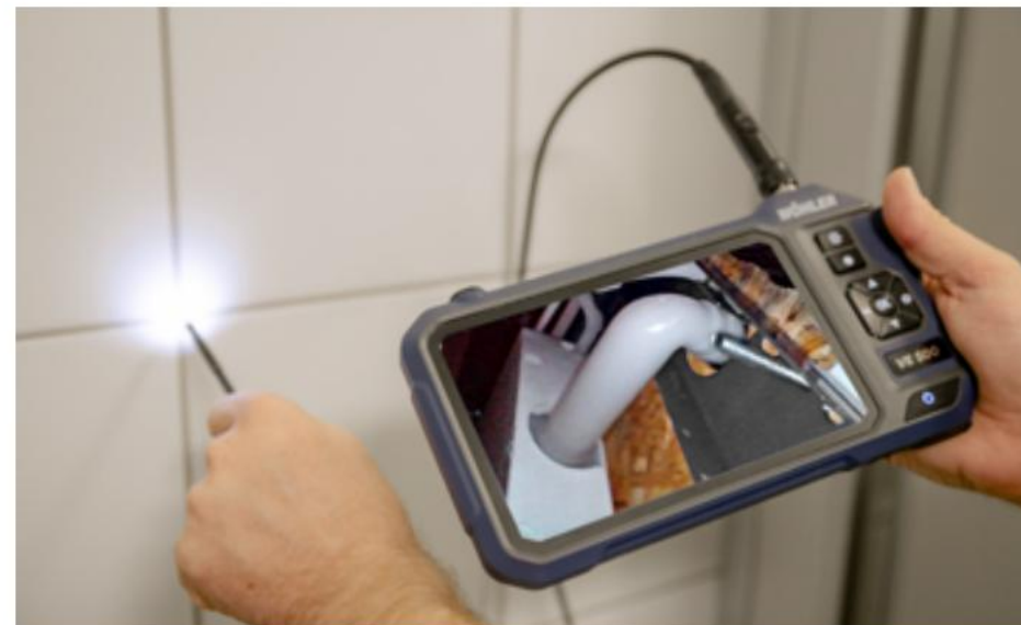
Para inspeccionar la instalación detrás de la pared es suficiente una abertura de Ø 6 mm en una cruz de azulejos.
